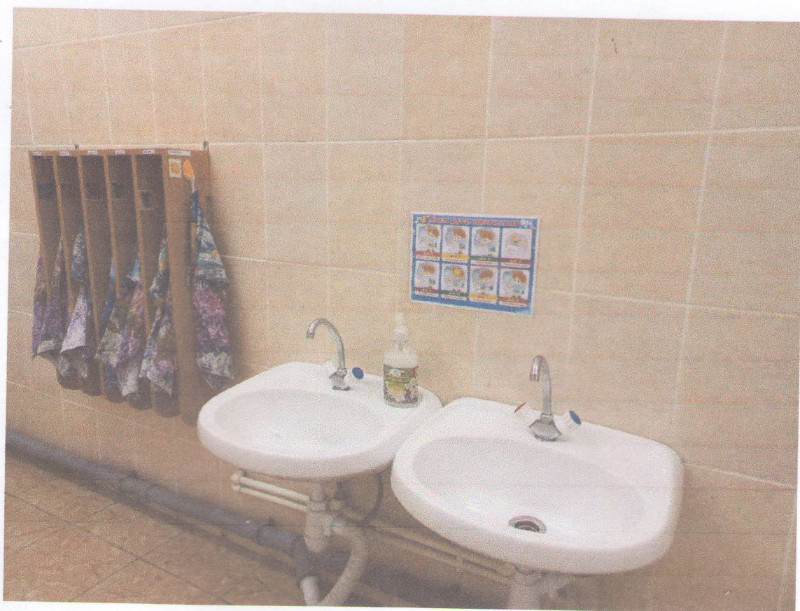
Санитарно-гигиенические помещения (фото 5)
